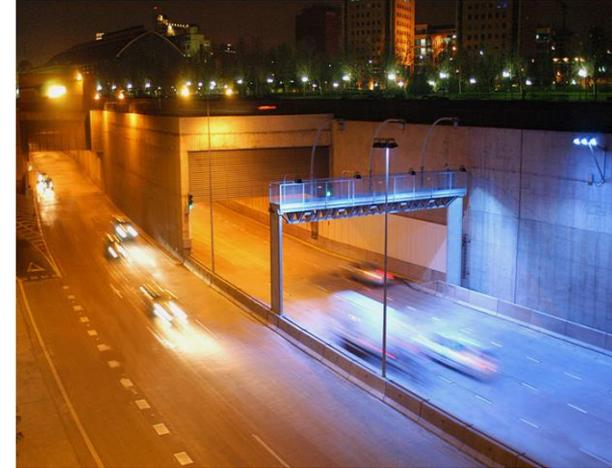
• Detector y clasificador de vehiculo    • Sensor de patente    • Antena lectora de TAG
