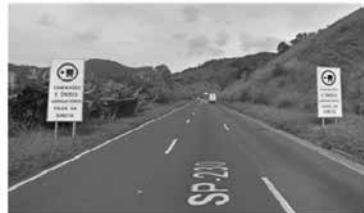
Depois da intervenção a partir dos resultados obtidos no simulador de direção – alteração da sinalização existente antes da curva no km 514+100 m da Rodovia Régis Bittencourt.
